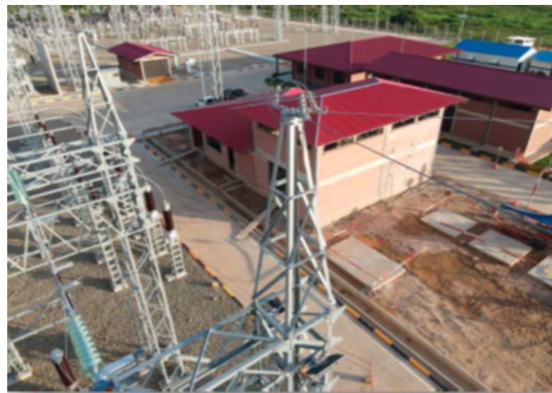
Obras civiles – Proyecto STATCOM – SE Paraíso
