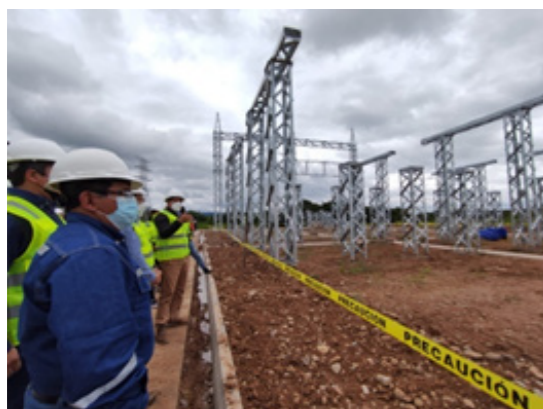
Inspección subestación Bermejo, Tarija
