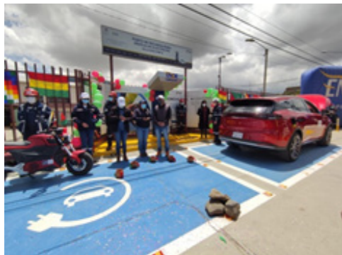
Estación de recarga para vehículos eléctricos, ciudad de El Alto.
