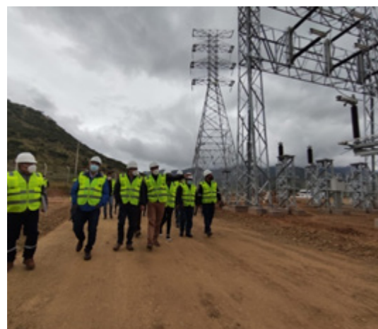
Inspección Subestación La Angostura, Tarija
