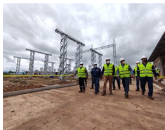
Ministro Molina encabeza inspección en la Subestación Bermejo
