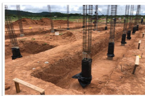
Sitio de construcción SE Brechas
