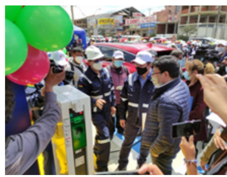
Ministro de Hidrocarburos y Energías, Lic. Franklin Molina verifica funcionamiento de la electrolinera en El Alto.
