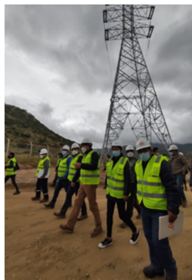
AETN acompaña inspección Subestación La Angostura, Tarija
